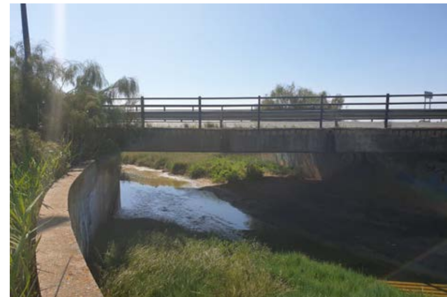
Imagen 22 – Fotografía del puente de la A-5055.
