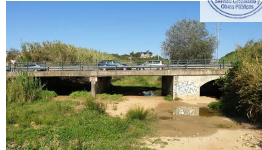
Imagen 21 – Fotografía del puente de la A-5056.
